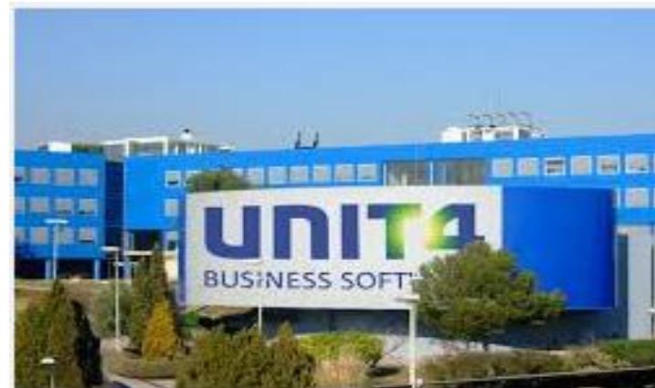
Oficina central de Barcelona
